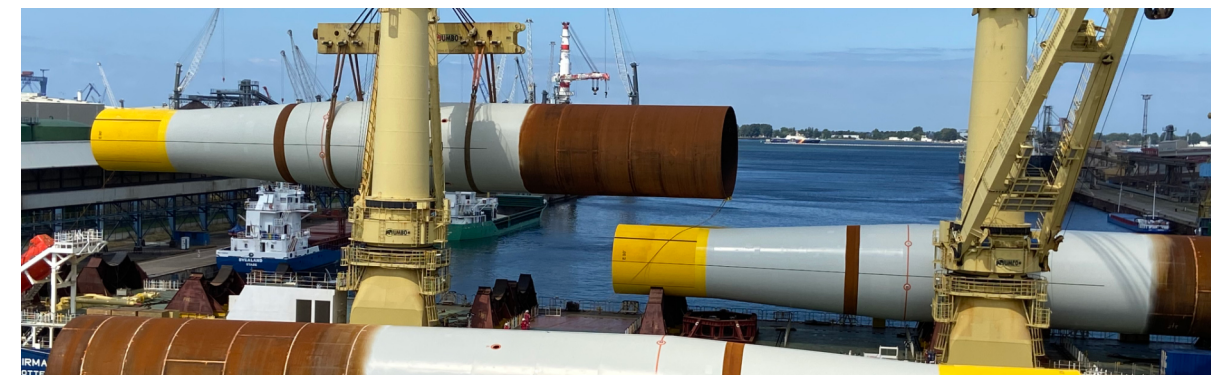
Abbildung 3: Verladung von Monopiles bei EEW SPC in Rostock, Quelle „EEW SPC“
