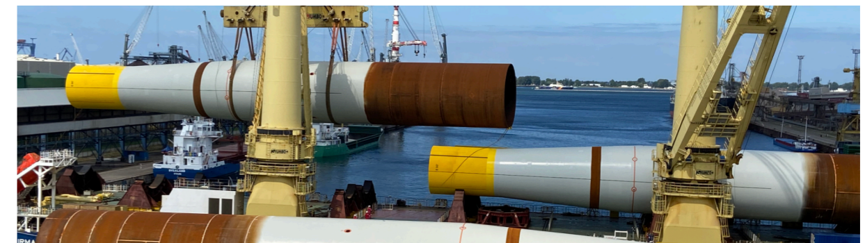
Verladung von Monopiles bei EEW SPC in Rostock, Quelle: EEW SPC
